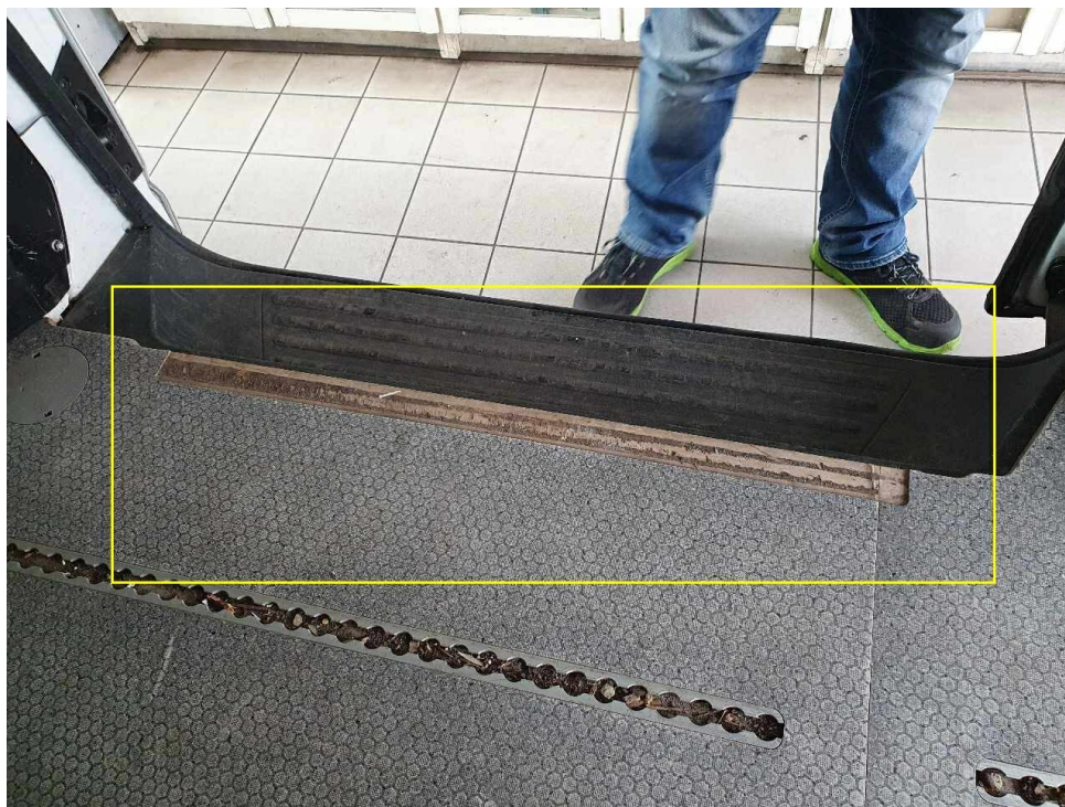
Bild 18 : Bodenbelag Laderaum Aluleiste abgebrochen
