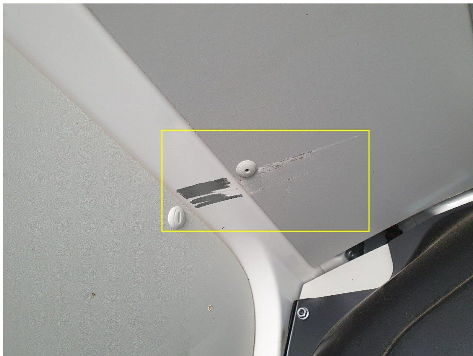
Bild 10 : Dachinnenseite links im Laderaum verschrammt
