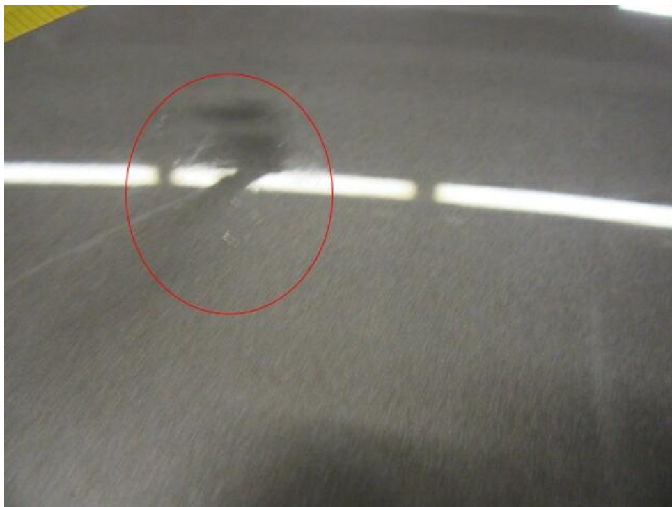
Bild 15 : Dachhaut: kleine Dellen
