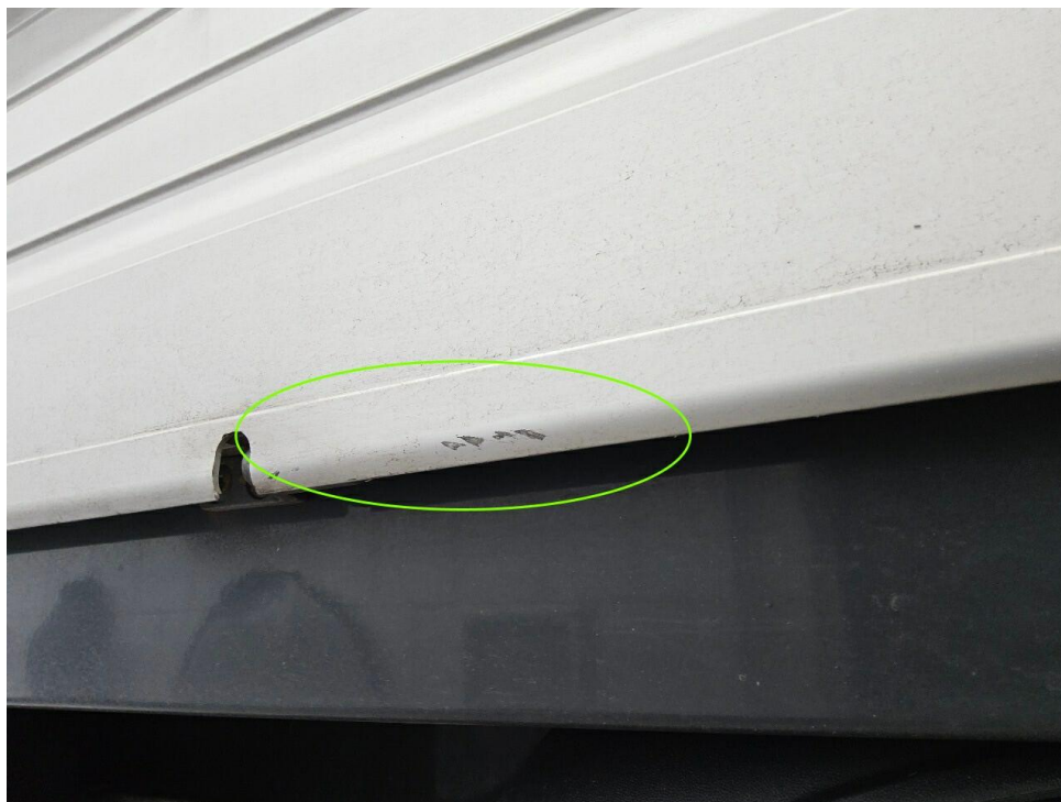
Bild 7 : Ladebordwand links, verformt und verschrammt
