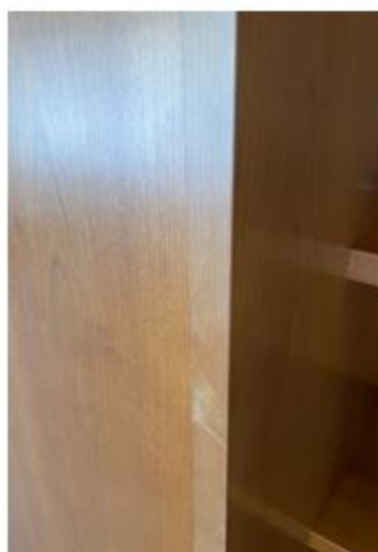
Furnierkante mit Gebrauchsspuren
