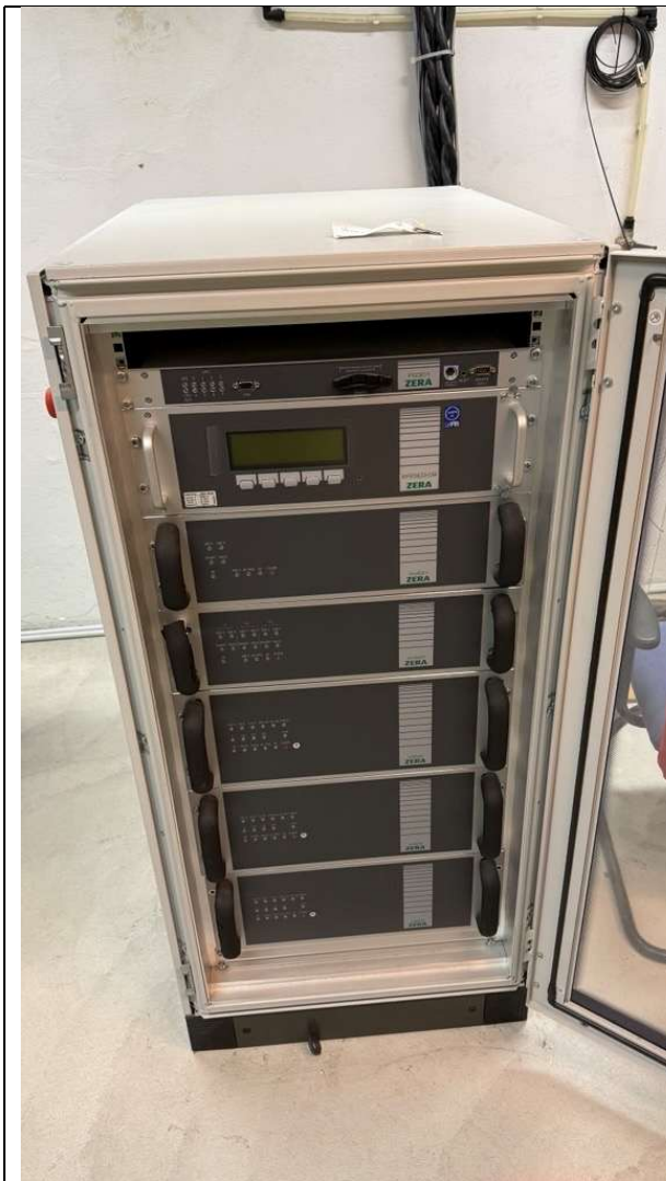
Versorgungsschrank mit Frequenzgenerator, Prüfzähler, Spannungs- und Stromverstärker
