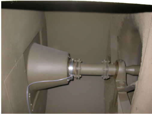
Innenansicht des Seitenanbaus
