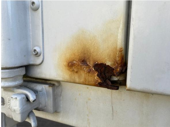
Bild 7: Tür links durchgerostet - instandsetzen und lackieren
