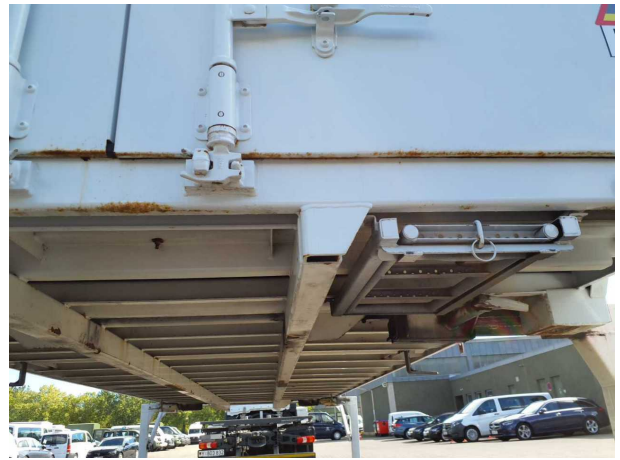
Gebrauchsspur 1: Karosserie: Karosserie - beschädigt - kein Abzug
