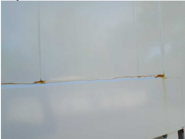
Gebrauchsspur 1: Karosserie: Karosserie - beschädigt - kein Abzug
