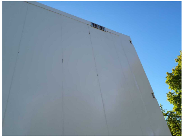
Gebrauchsspur 1: Karosserie: Karosserie - beschädigt - kein Abzug
