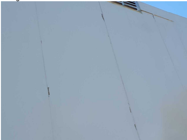
Gebrauchsspur 1: Karosserie: Karosserie - beschädigt - kein Abzug
