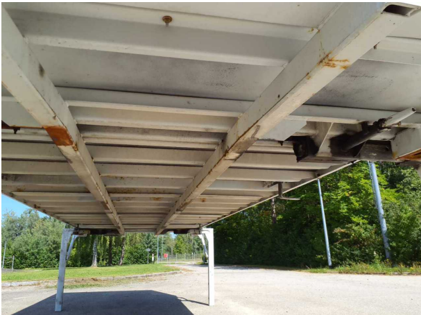
Gebrauchsspur 1: Karosserie: Karosserie - Korrosion - kein Abzug
