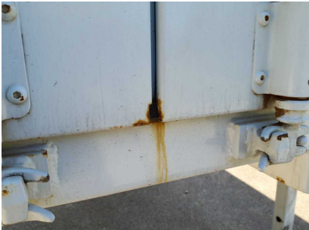
Gebrauchsspur 1: Karosserie: Karosserie - Korrosion - kein Abzug
