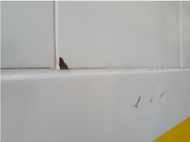
Gebrauchsspur 1: Karosserie: Karosserie - Korrosion - kein Abzug
