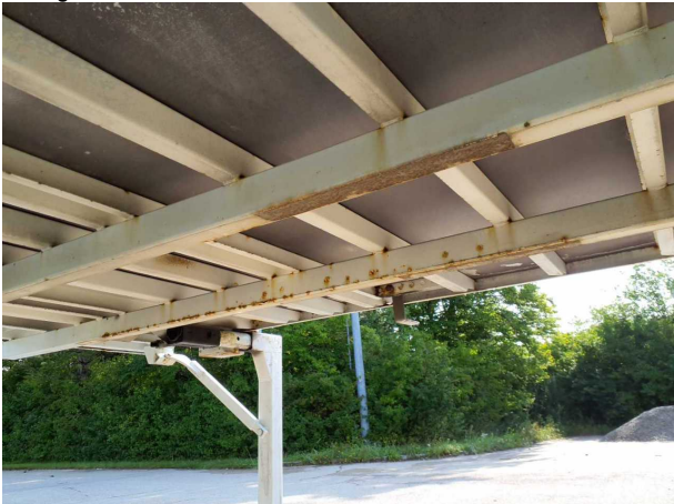
Gebrauchsspur 1: Karosserie: Karosserie - Korrosion - kein Abzug
