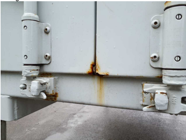
Gebrauchsspur 1: Karosserie: Karosserie - beschädigt - kein Abzug
