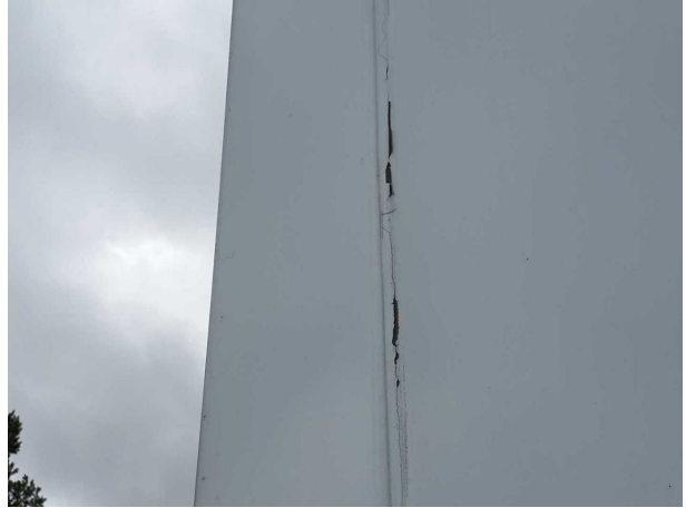
Gebrauchsspur 1: Karosserie: Karosserie - beschädigt - kein Abzug
