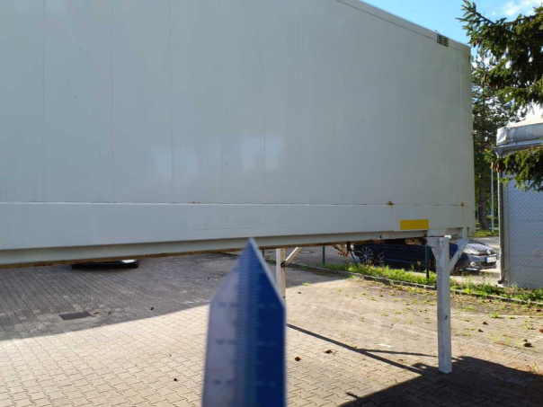
Beschädigung 2: Seitenwand links: Seitenwand - verkratzt / verschürft - instandsetzen und lackieren
