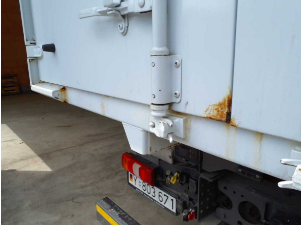
Gebrauchsspur 1: Karosserie: Karosserie - Korrosion - kein Abzug
