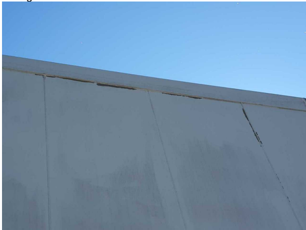
Gebrauchsspur 1: Karosserie: Karosserie - beschädigt - kein Abzug
