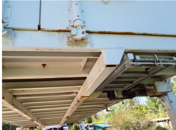
Gebrauchsspur 1: Karosserie: Karosserie - beschädigt - kein Abzug
