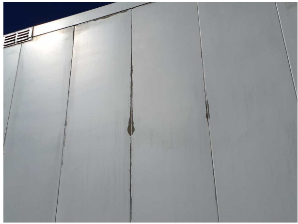
Gebrauchsspur 1: Karosserie: Karosserie - beschädigt - kein Abzug
