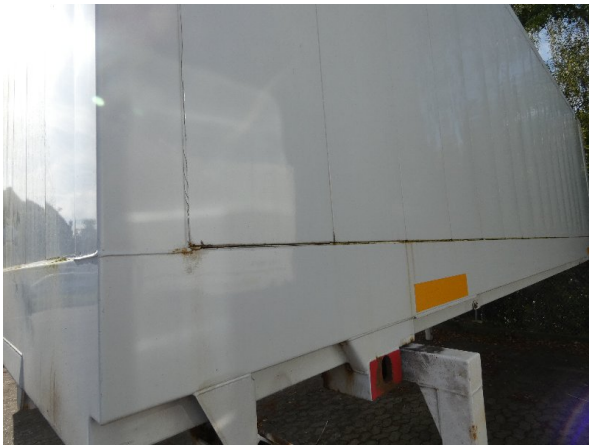
Bild 19: Seitenwand links außen Karrosseriedichtnaht fehlt - instandsetzen
