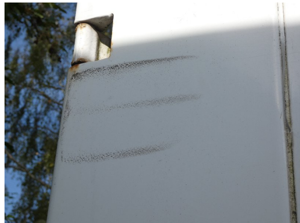
Bild 18: Portalrahmen rechts Kratzer - ohne Reparatur
