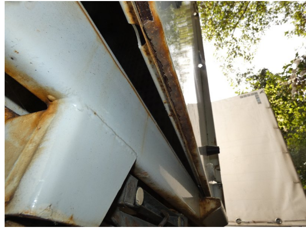
Bild 16: Hecktür rechts Korrosion - teillackieren
