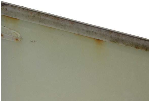
Bild 17: Hecktür links Korrosion - teillackieren
