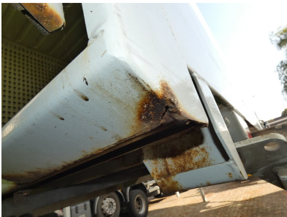
Bild 13: Portalrahmen unten Korrosion - lackieren
