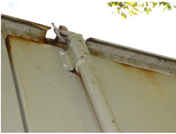
Bild 19: Hecktür rechts Korrosion - teillackieren
