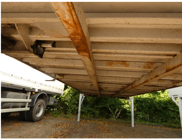
Bild 7: Rahmen und Stützbeine Korrosion - ohne Reparatur
