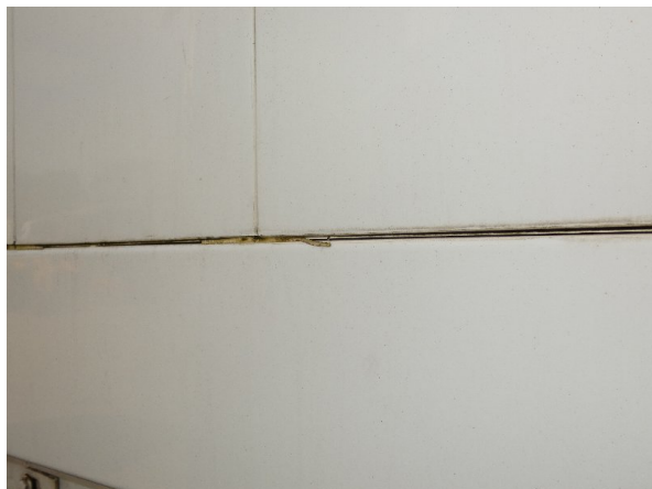
Bild 25: Seitenwand links Lackablösung, Korrosion - teillackieren
