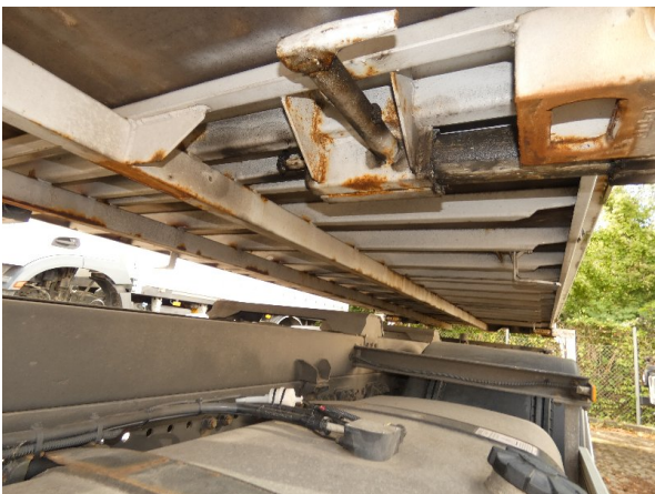
Bild 18: Rahmen und Stützbeine Korrosion - ohne Reparatur
