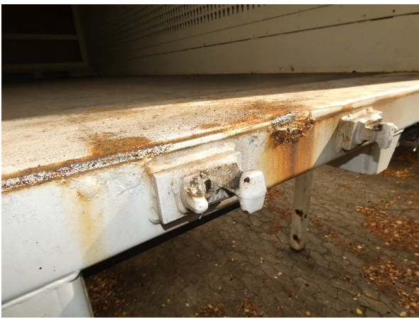
Bild 14: Portalrahmen unten Korrosion - lackieren
