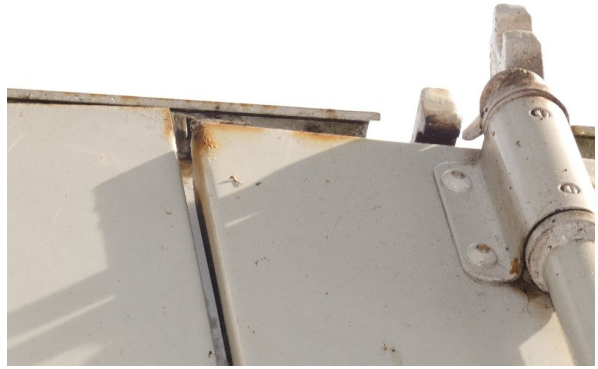
Bild 8: Hecktür rechts Korrosion - teillackieren
