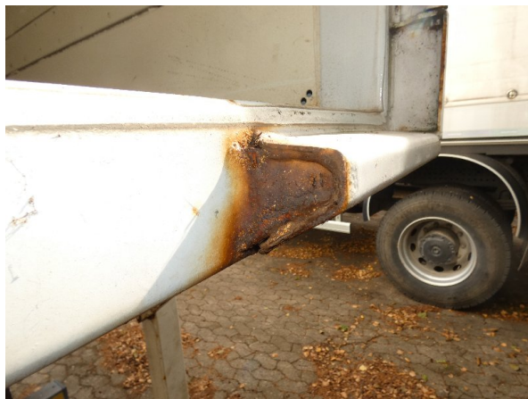
Bild 15: Portalrahmen unten Korrosion - lackieren
