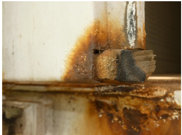
Bild 10: Hecktür links Korrosion - teillackieren
