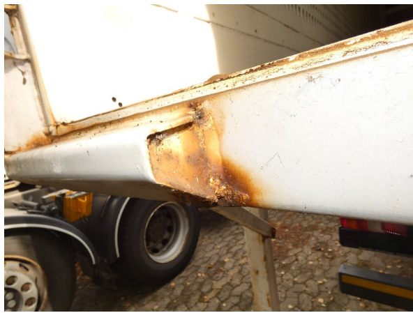
Bild 13: Portalrahmen unten Korrosion - lackieren
