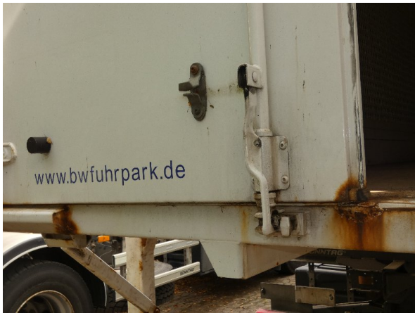
Bild 9: Hecktür links Korrosion - teillackieren
