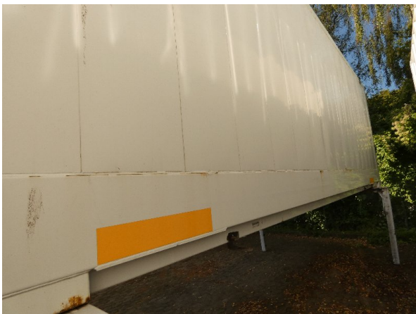
Bild 14: Unterzug links Korrosion - lackieren
