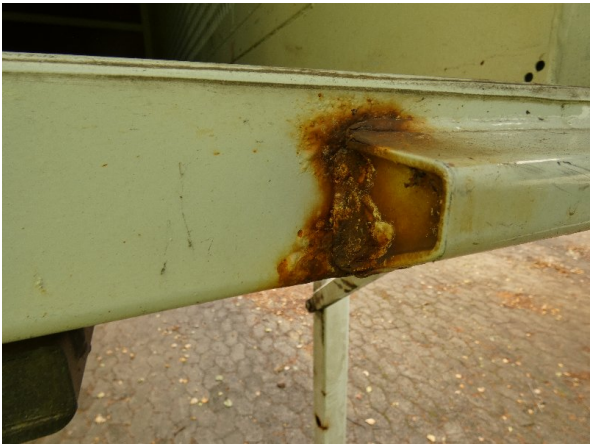
Bild 30: Portalrahmen unten Korrosion - lackieren
