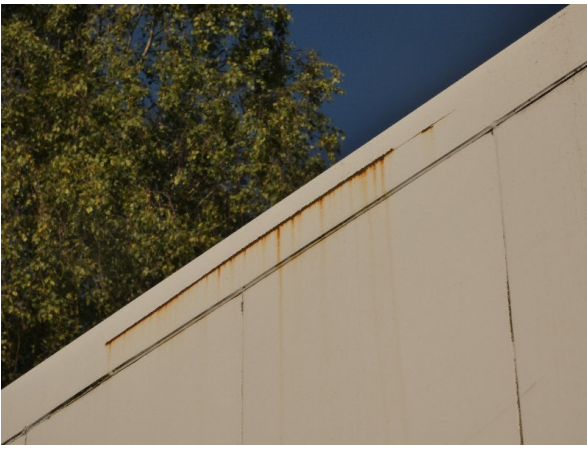
Bild 25: Oberzug rechts verkratzt - lackieren
