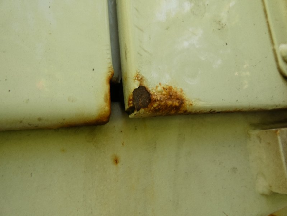
Bild 10: Hecktür rechts Korrosion - teillackieren
