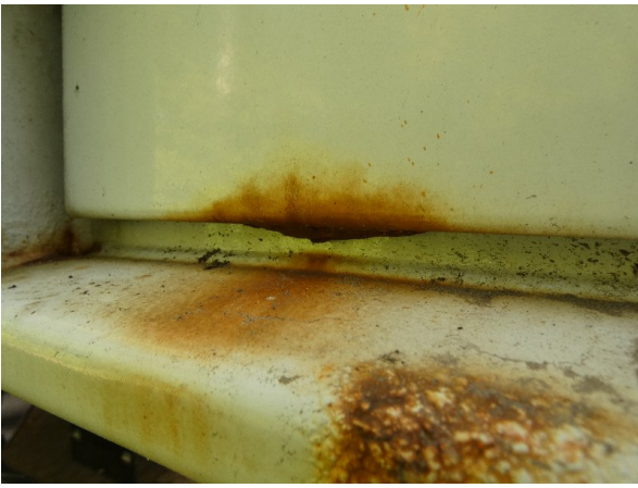
Bild 7: Hecktür links Korrosion - teillackieren
