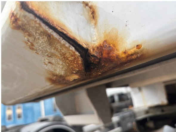
Bild 5: Container Korrosion - instandsetzen und lackieren
