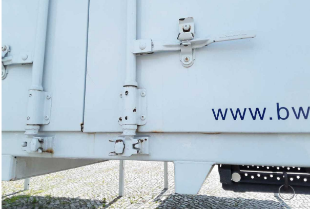
Beschädigung 1: Sonstiges: Sonstiges (Scharniere beider Türen schwergängig) - Funktion / Zulässigkeit - instandsetzen
