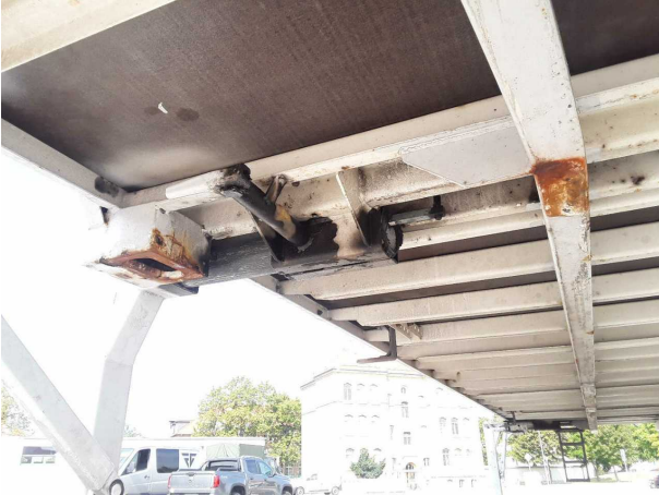
Gebrauchsspur 1: Sonstiges: Sonstiges (Rahmengruppe) - Korrosion - kein Abzug
