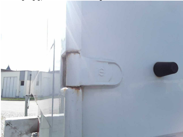
Beschädigung 1: Sonstiges: Sonstiges (Scharniere beider Türen schwergängig) - Funktion / Zulässigkeit - instandsetzen
