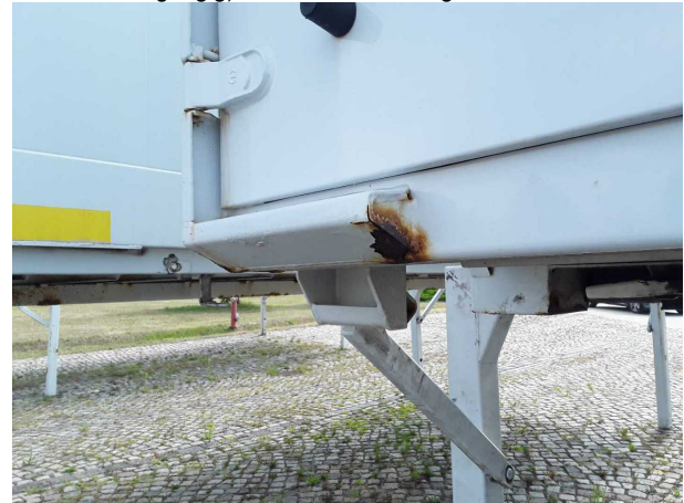
Gebrauchsspur 1: Sonstiges: Sonstiges (Rahmengruppe) - Korrosion - kein Abzug
