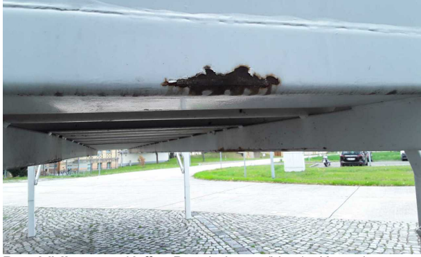
Beschädigung 4: Koffer: Portalrahmen (Vorn) - Korrosion - instandsetzen und lackieren
