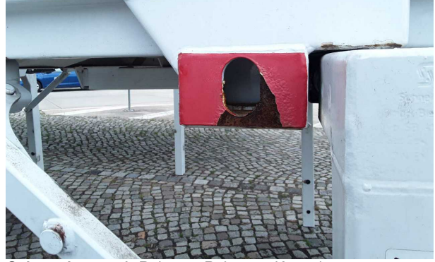
Gebrauchsspur 1: Rahmen: Rahmen - Korrosion
