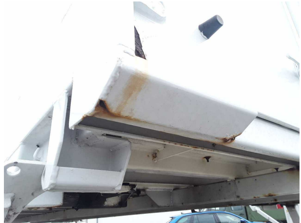
Gebrauchsspur 2: Koffer: Portalrahmen (Hinten) - Korrosion - kein Abzug
