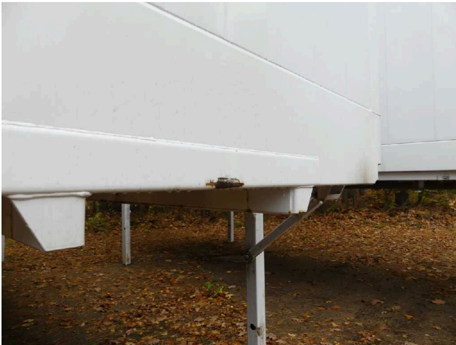
Bild 9 Aufbau Bodenrahmen vorne korrodiert
