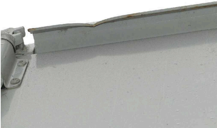
Bild 52 Dach Dach hinten rechts eingedrückt
