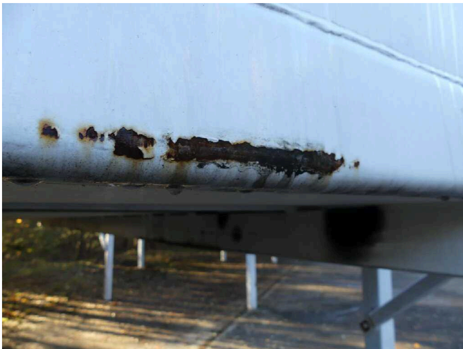
Bild 10 Aufbau Bodenrahmen vorne korrodiert
