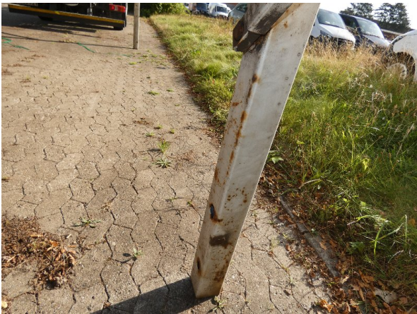
Bild 12: Rahmen und Stützbeine Korrosion - ohne Reparatur
