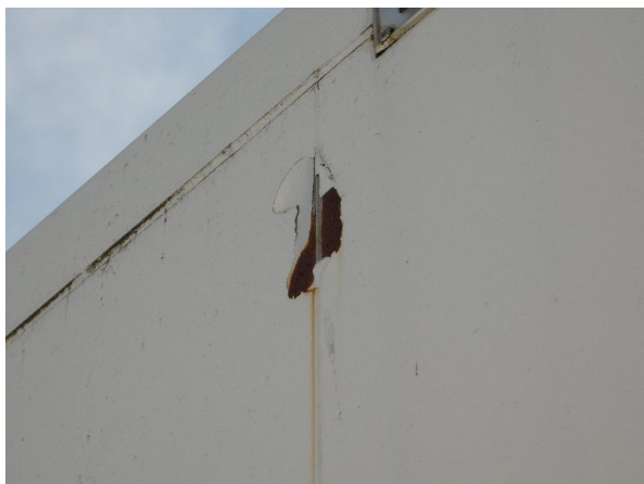
Bild 18: Seritenwand links außen Korrosion / Lackablösung - teillackieren
