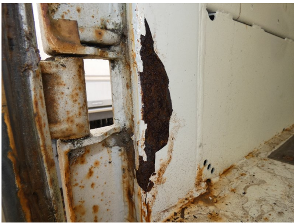
Bild 7: Portalrahmen links Korrosion - teillackieren
