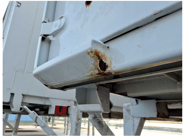
Beschädigung 4: Koffer: Portalrahmen - Korrosion - instandsetzen und lackieren
