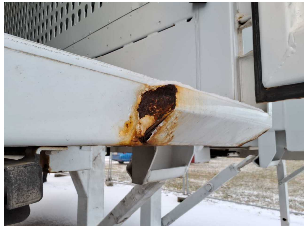
Beschädigung 2: Koffer: Portalrahmen - Korrosion - instandsetzen und lackieren
