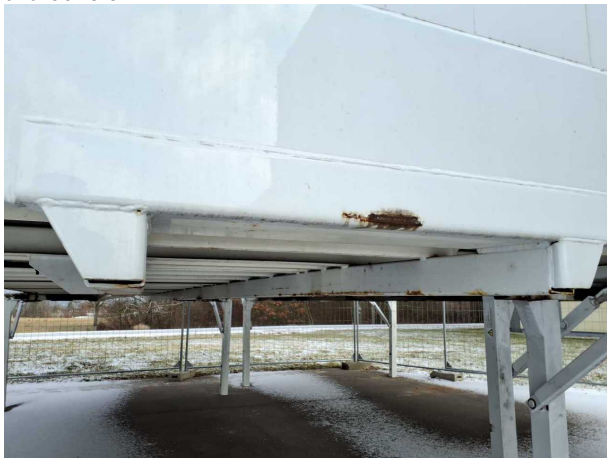
Gebrauchsspur 1: Koffer: Koffer - Korrosion
