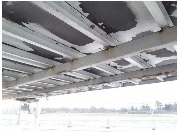
Gebrauchsspur 1: Koffer: Koffer - Korrosion - kein Abzug
