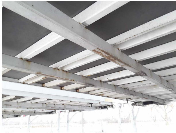
Gebrauchsspur 1: Koffer: Koffer - Korrosion - kein Abzug
