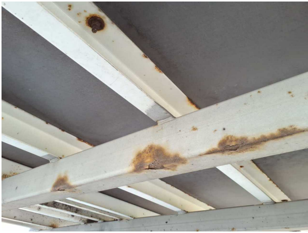
Gebrauchsspur 1: Koffer: Koffer - Korrosion - kein Abzug
