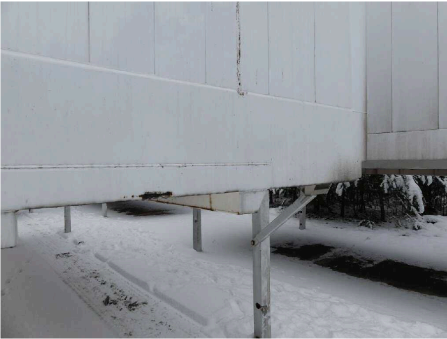
Bild 9 Aufbau Bodenrahmen vorne korrodiert
