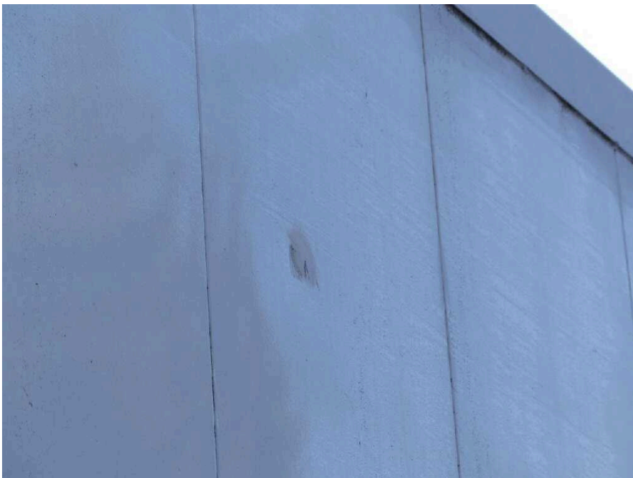
Bild 14 linke Seite Seitenwand links eingedrückt
