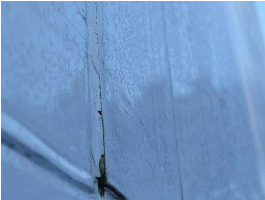
Bild 43 linke Seite Seitenwand links und Ecke hi.re. verschürft
