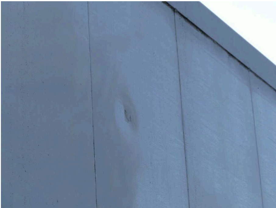
Bild 13 linke Seite Seitenwand links eingedrückt
