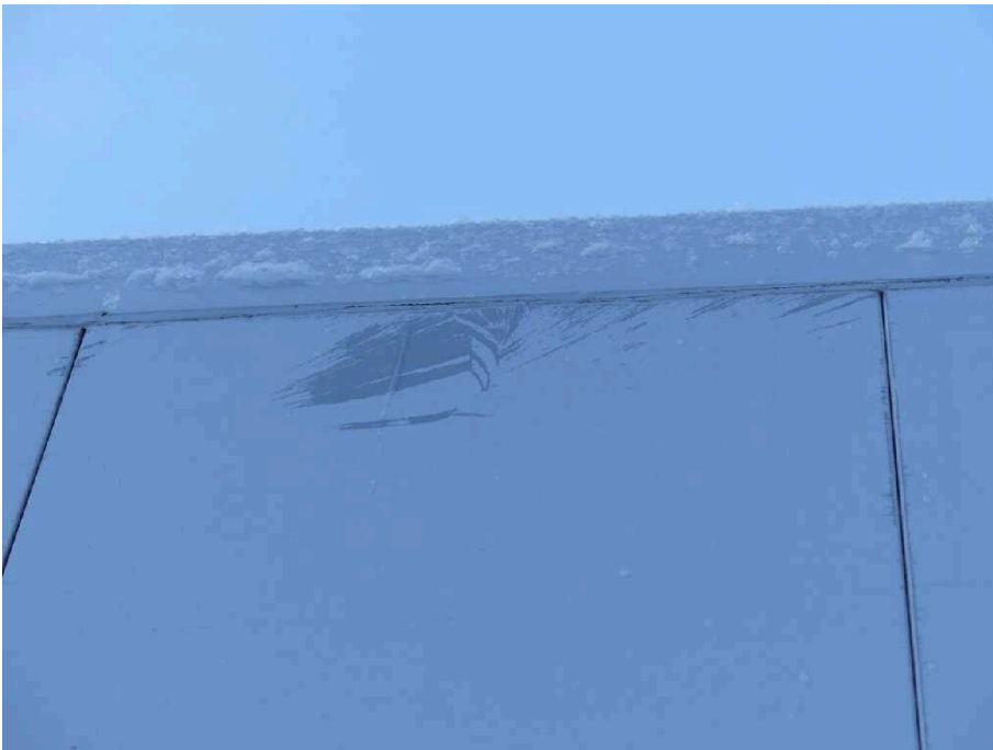
Bild 19 linke Seite Seitenwand links verkratzt
