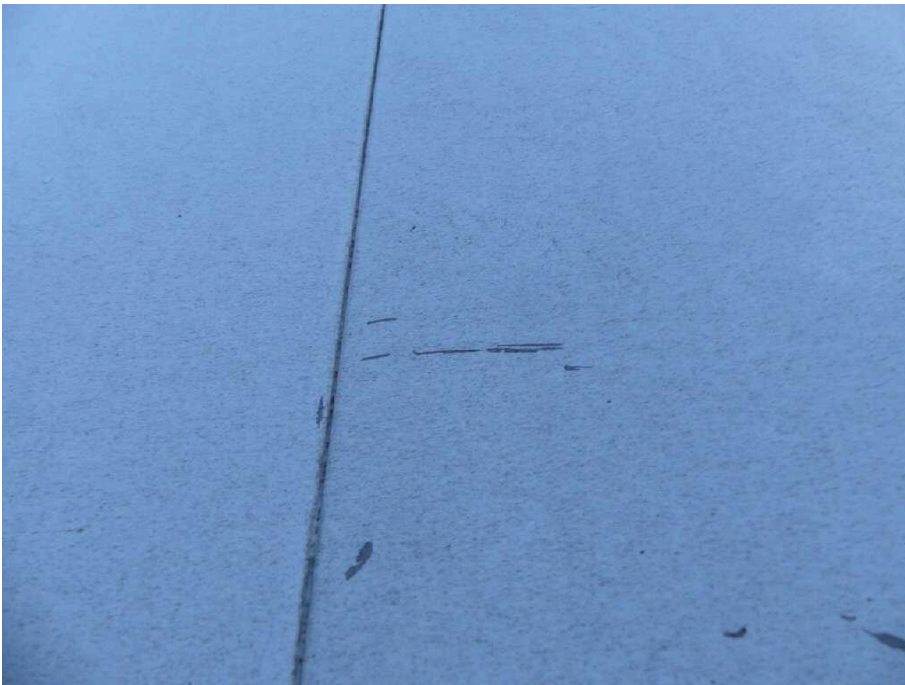
Bild 28 linke Seite Seitenwand links verkratzt
