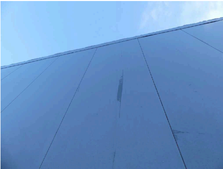
Bild 29 linke Seite Seitenwand links verkratzt
