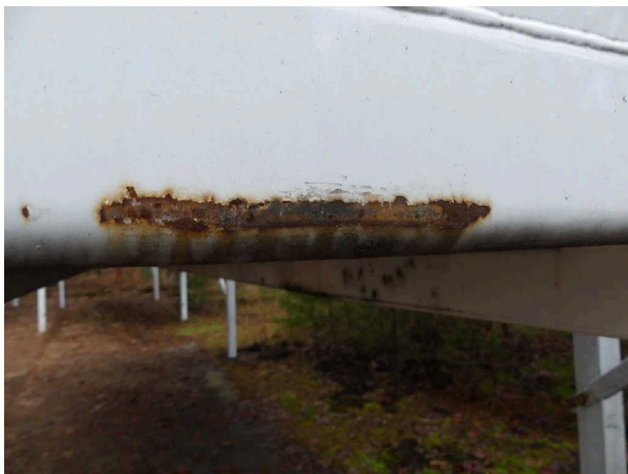
Bild 10 Aufbau Bodenrahmen vorne korrodiert
