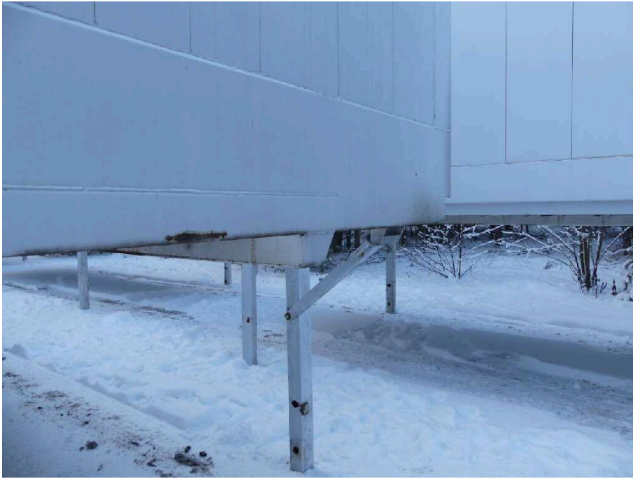
Bild 9 Aufbau Bodenrahmen vorne korrodiert
