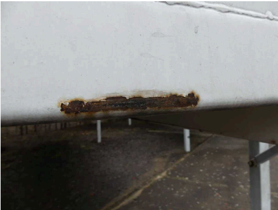
Bild 10 Aufbau Bodenrahmen vorne korrodiert
