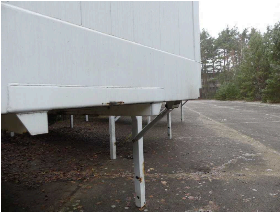
Bild 9 Aufbau Bodenrahmen vorne korrodiert
