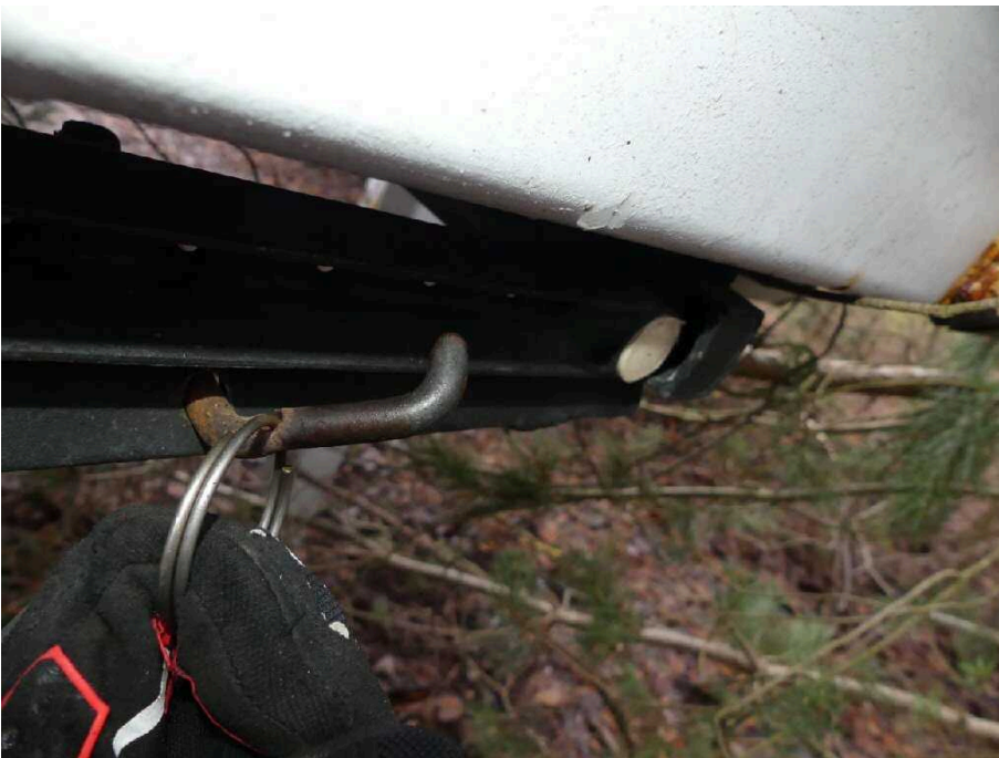
Bild 44 Aufbau Aufstiegsleiter hinten Sicherung beschädigt
