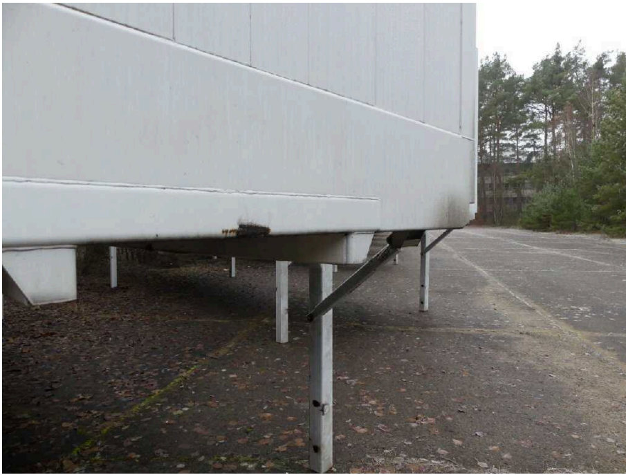
Bild 9 Aufbau Bodenrahmen vorne korrodiert
