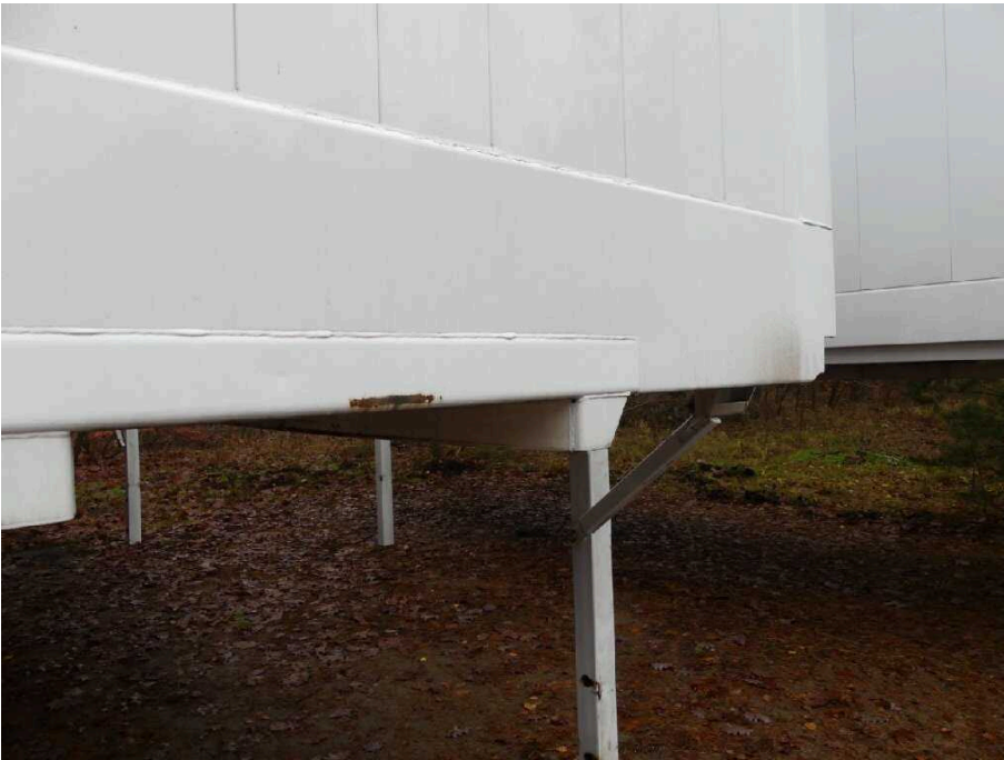
Bild 9 Aufbau Bodenrahmen vorne korrodiert
