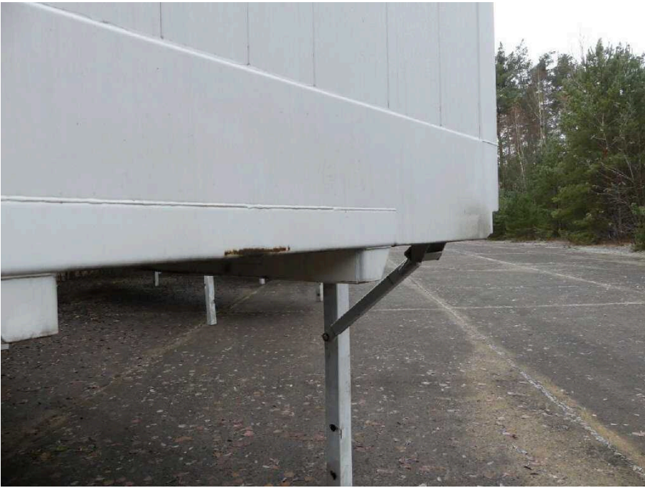
Bild 9 Aufbau Bodenrahmen vorne korrodiert
