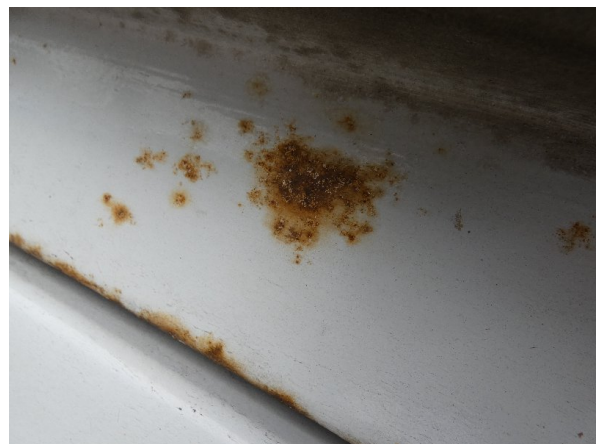
Bild 18: Seitenwand Korrosion - instandsetzen und lackieren
