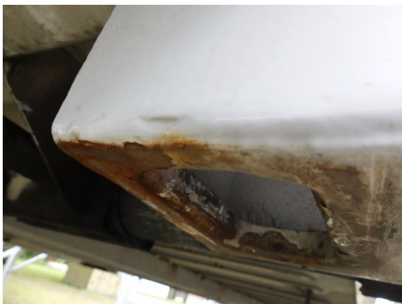
Bild 27: Aufnahmen Korrosion-instandsetzen und lackieren
