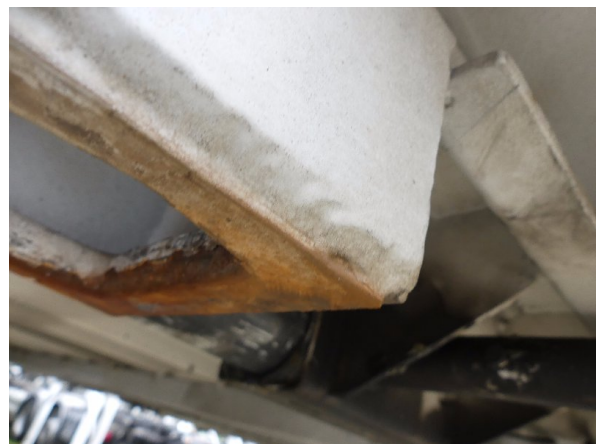
Bild 28: Aufnahmen Korrosion-instandsetzen und lackieren
