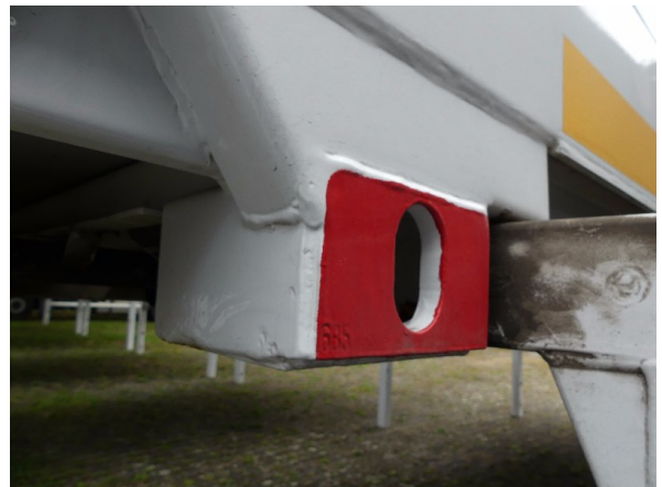
Bild 26: Aufnahmen Korrosion-instandsetzen und lackieren
