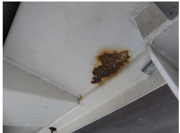
Bild 32: Unterboden Korrosion - instandsetzen und lackieren
