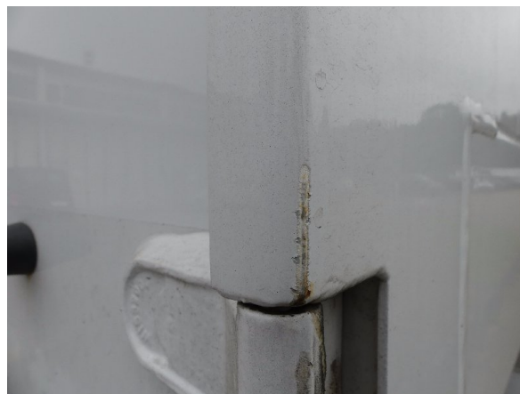
Bild 16: Eckbeplankung rechts Korrosion - instandsetzen und lackieren
