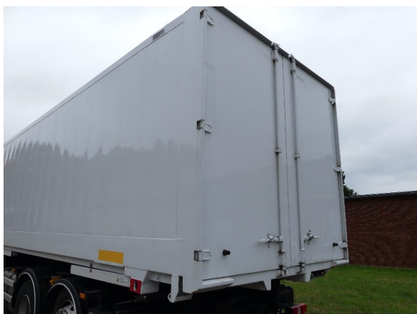
Bild 17: Eckbeplankung links Korrosion - instandsetzen und lackieren
