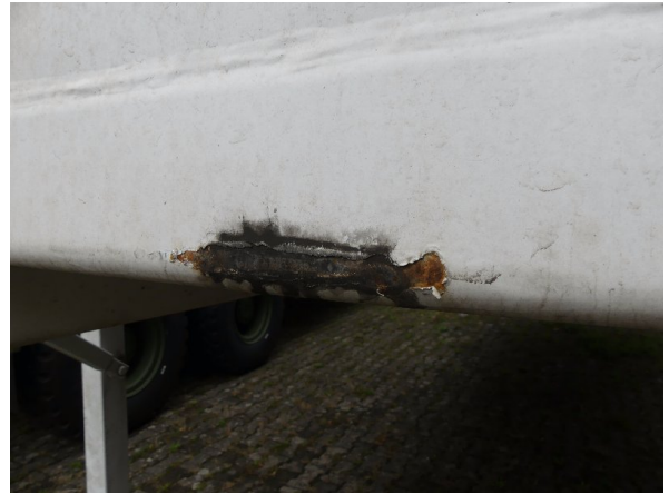
Bild 24: Frontwand Korrosion - instandsetzen und lackieren
