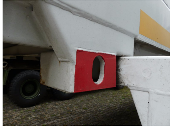
Bild 30: Aufnahmen Korrosion-instandsetzen und lackieren
