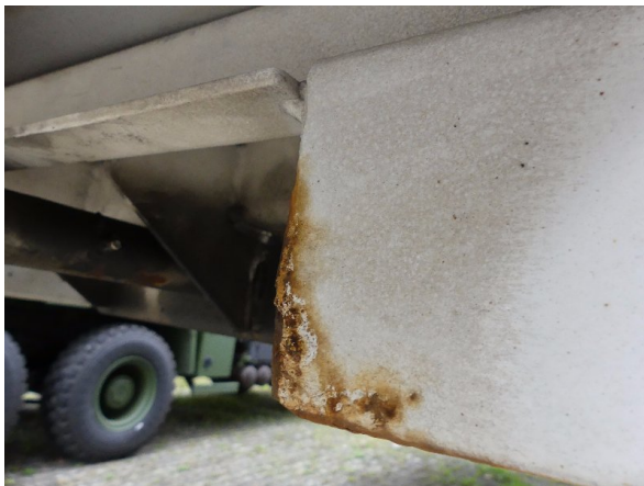
Bild 31: Aufnahmen Korrosion-instandsetzen und lackieren
