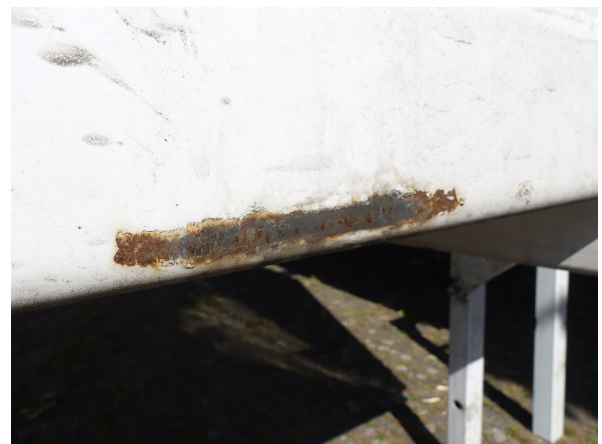
Bild 12: Frontwand Korrosion - instandsetzen und lackieren
