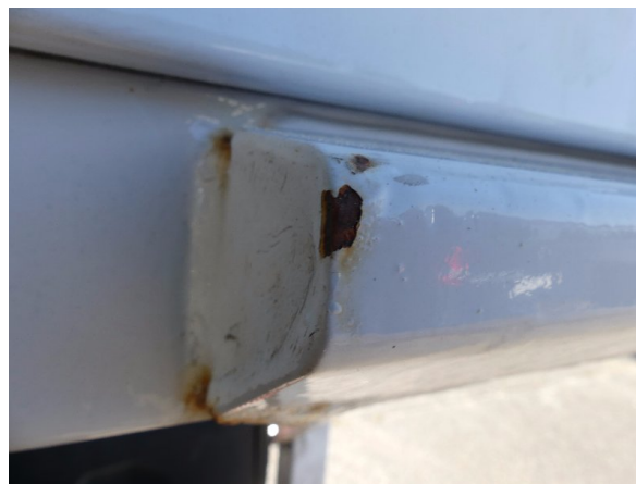
Bild 14: Eckbeplankung rechts Korrosion - instandsetzen und lackieren
