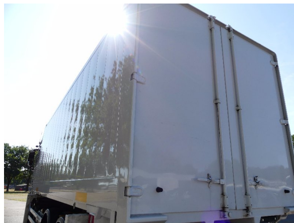
Bild 16: Eckbeplankung links Korrosion - instandsetzen und lackieren
