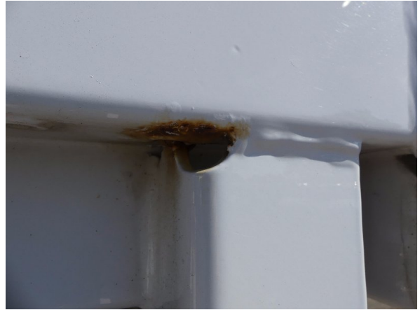
Bild 20: Seitenwand Korrosion - instandsetzen und lackieren
