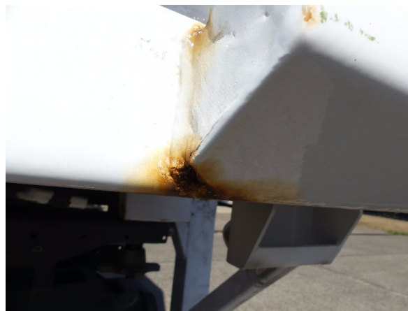
Bild 14: Eckbeplankung rechts Korrosion - instandsetzen und lackieren
