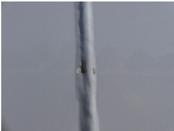
Bild 21: Seitenwand Korrosion - instandsetzen und lackieren
