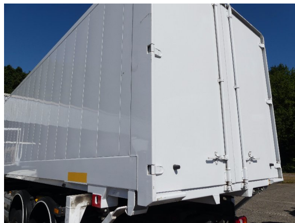
Bild 16: Eckbeplankung links Korrosion - instandsetzen und lackieren
