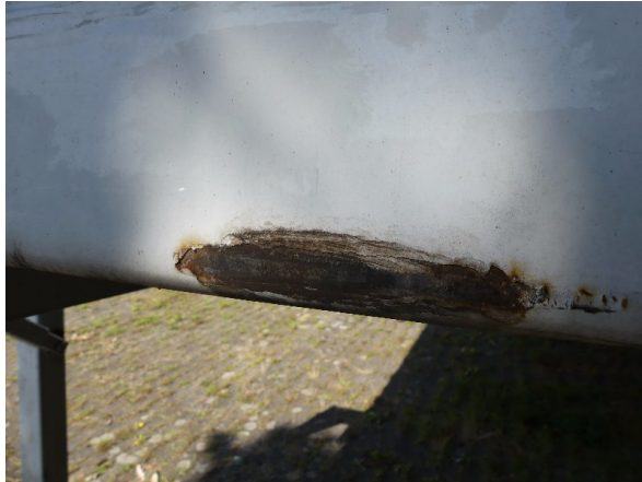
Bild 25: Frontwand Korrosion - instandsetzen und lackieren
