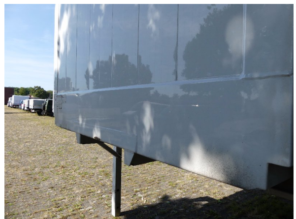
Bild 24: Frontwand Korrosion - instandsetzen und lackieren
