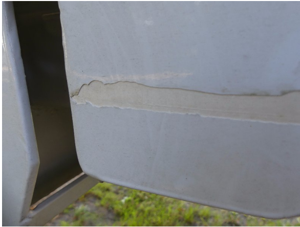
Bild 33: Eckbeplankung links Korrosion - instandsetzen und lackieren
