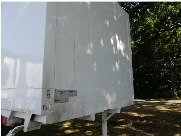
Bild 15: Frontwand Korrosion - instandsetzen und lackieren
