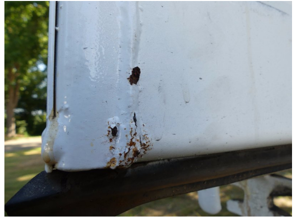
Bild 14: Hecktür links Korrosion - instandsetzen und lackieren
