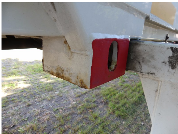
Bild 21: Aufnahmen Korrosion - instandsetzen und lackieren
