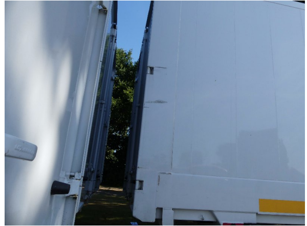
Bild 30: Eckbeplankung rechts Korrosion - instandsetzen und lackieren
