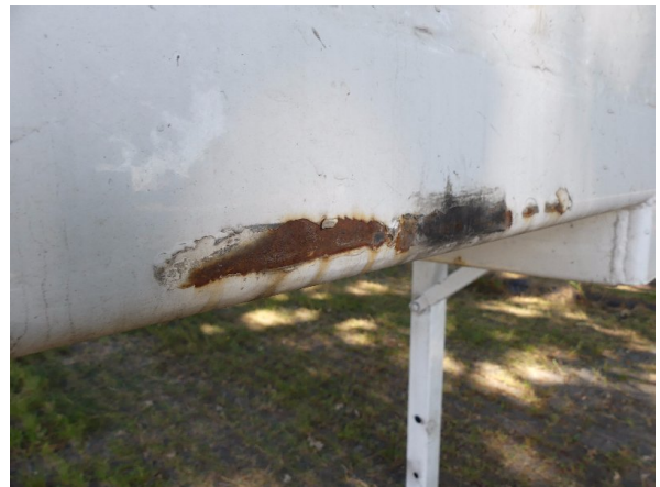
Bild 16: Frontwand Korrosion - instandsetzen und lackieren
