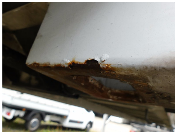
Bild 26: Aufnahmen Korrosion-instandsetzen und lackieren
