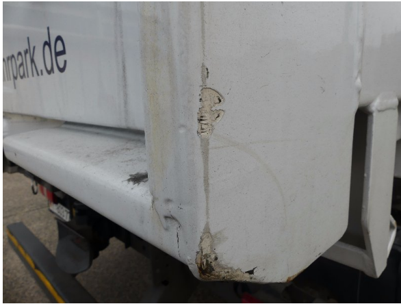
Bild 13: Eckbeplankung rechts Korrosion - instandsetzen und lackieren
