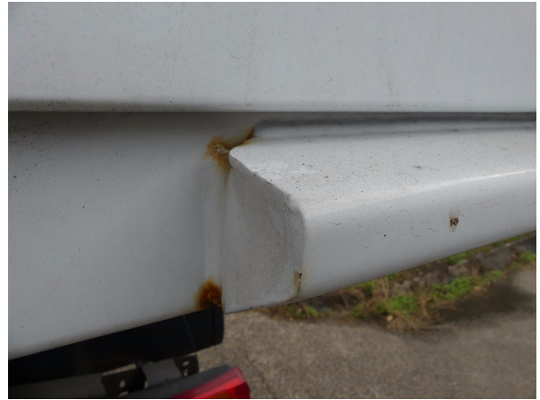
Bild 14: Eckbeplankung rechts Korrosion - instandsetzen und lackieren
