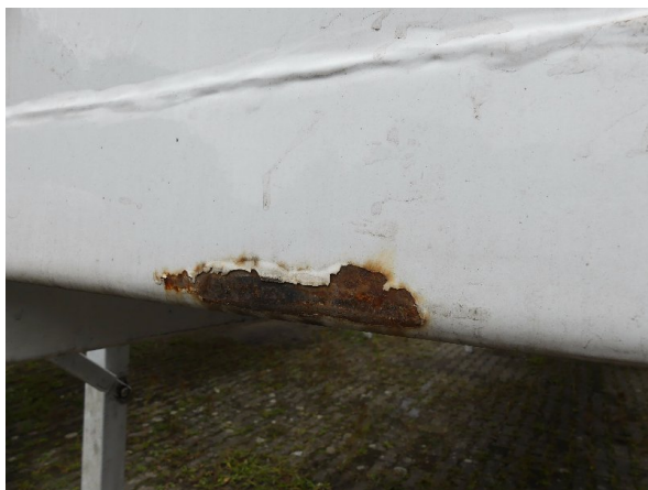
Bild 23: Frontwand Korrosion - instandsetzen und lackieren
